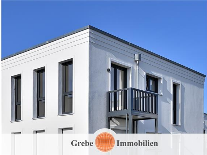
Tempelhofer Straße 10 in Zossen
